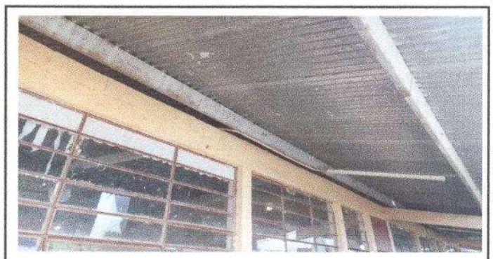
Foto 4: Mantenimiento a estructura de soporte de metal
