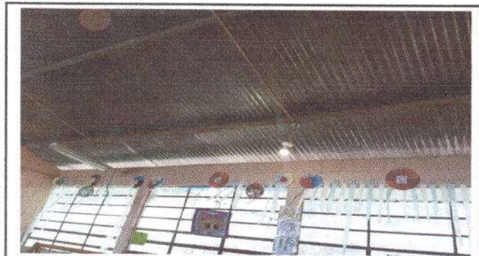
Foto 3: Mantenimiento a estructura de soporte de metal
